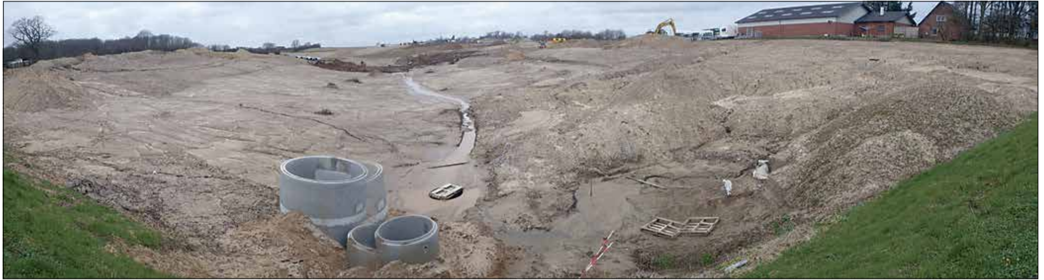
Via afløbet i forgrunden løb masser af sandholdigt vand videre til vandløbet.
