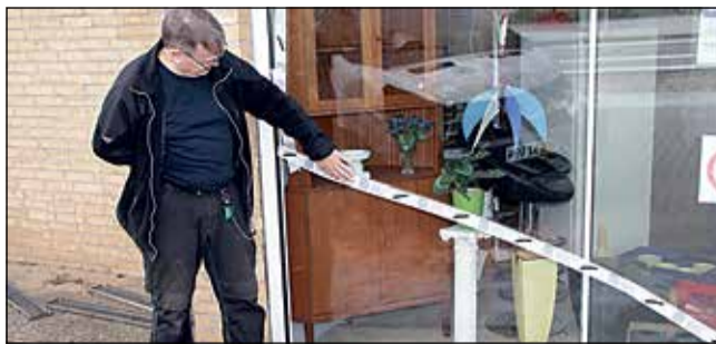
Glasindgangen flækkede på grund af varmen og skal udskiftes.
