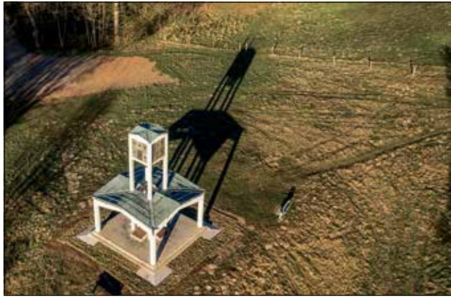
Den nyrestaurerede klokkestabel. Alle foto af Palle Skov.
