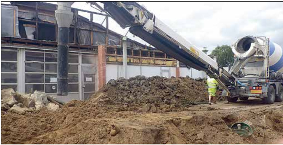
Ved hjælp af et langt rullende bånd blev cementen ført ned i jorden.
