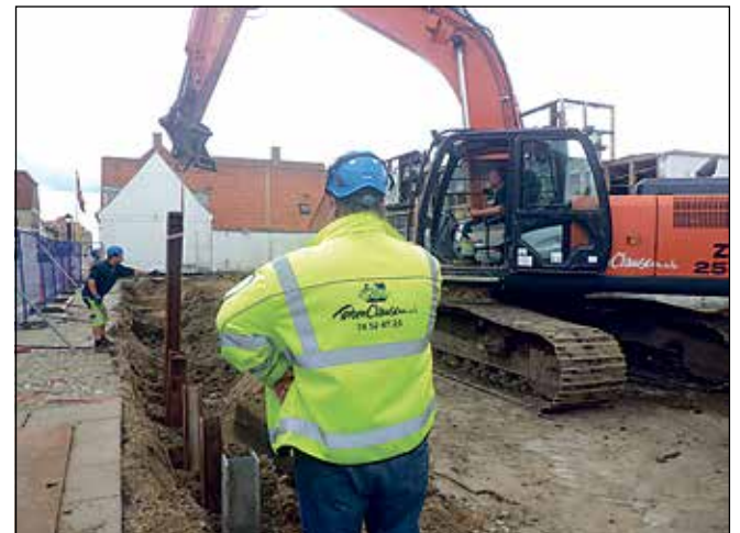
Her sænkes profilbjælker ned i cementen.
